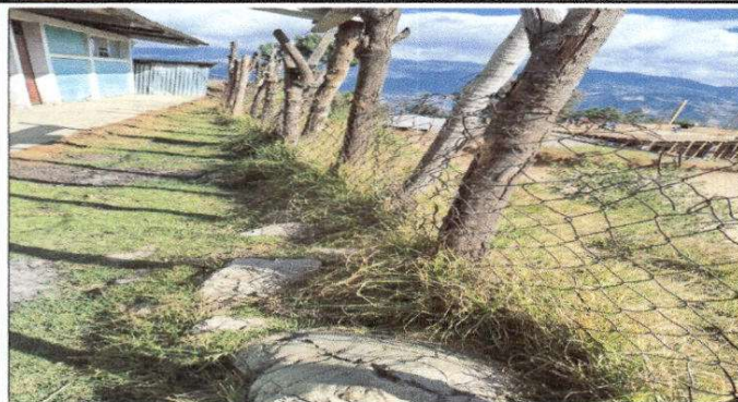
Foto 7: Reparación de malla galvanizada más tubo Hg
