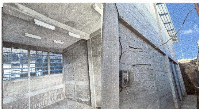
Foto 5: Pintura en muros exteriores e interiores
