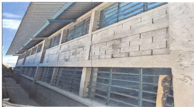
Foto 4: Canales y bajadas de aguas pluviales
