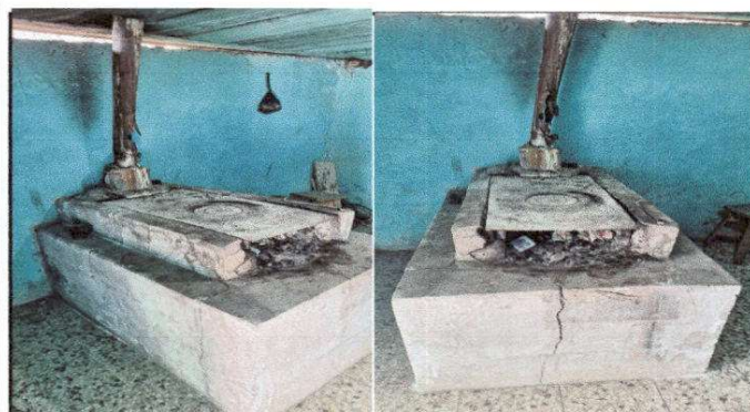
Foto 9 :Sustitución de plancha de metal de 3 Hornillas
